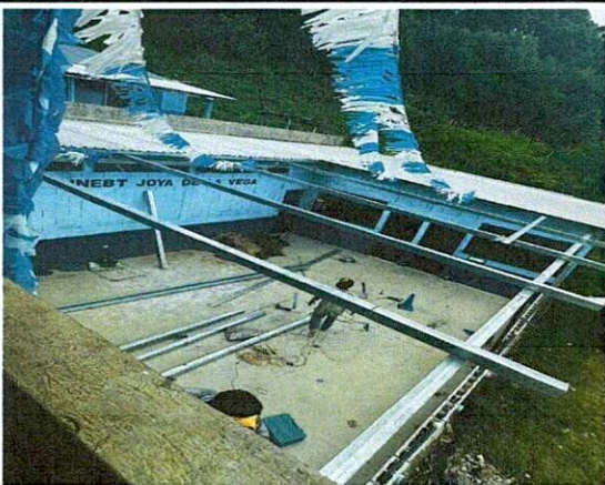
Foto1: Instalación de techo con estructura de metal y cobertura de lámina troquelada calibre 26 en el patio.
