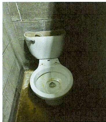
Foto 2: Mejoramiento de los baños, puertas, accesorios y la instalación de red de agua.
